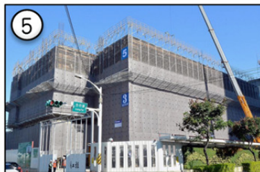
□ 西北側興建中之中路二號 社會住宅
